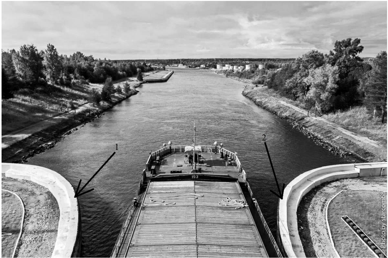
Рис. 1. Вид на входные палы нижней головы судоходного шлюза. 1 – левая входная пала; 2 – правая входная пала. Фото из открытых источников
